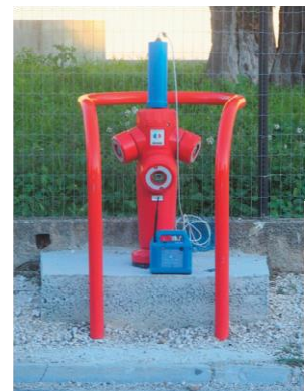
Inyección en la boca de incendios
